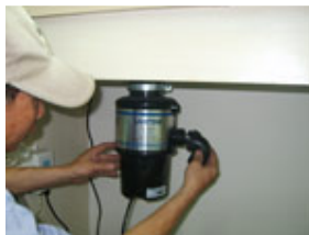
4. Anslut vinklade avloppsroret till kvarnen.
