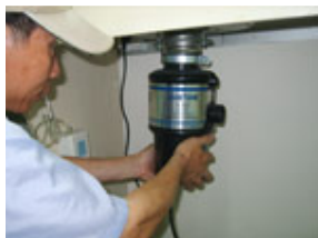
3. Fäst kvarnen på monteringsringen.
