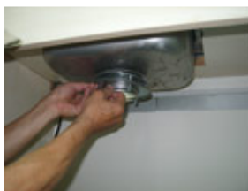
2. Fixera monteringsringen under diskhon.
